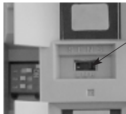
Microinterruttore di selezione della sensibilità (L, M, H)
