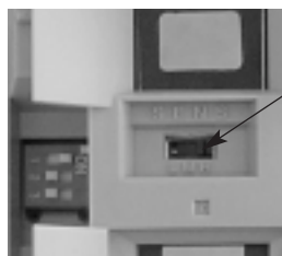
Micro-interrupteur de sélection de la sensibilité (L, M, H)
