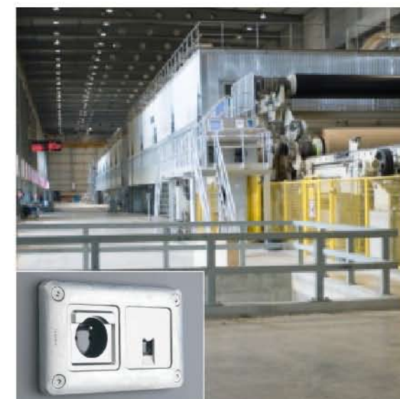
ENTREPÔT | Prise 2P+T + prise RJ 45
