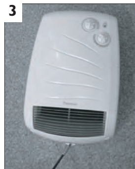
Faites glisser l'appareil dans les encoches des 2 vis supérieures. Immobilisez l'appareil avec la vis du bas.
